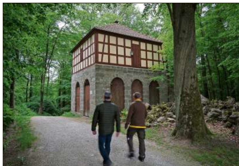
Der Wasserturm zwei ist nicht weit vom Kanalgarten im Wald versteckt. Sein Tank fasst ebenfalls 50 000 Liter Wasser.
